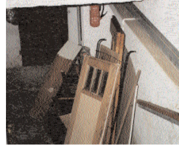
Abgestellter Sperrmüll verqualmt im Brandfall den Treppenraum und versperrt den Fluchtweg.
