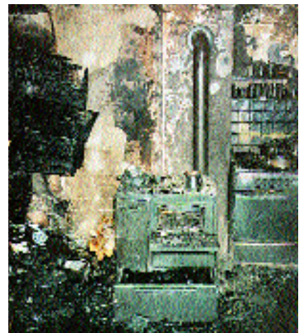
Brand durch herausgefallene Glut
